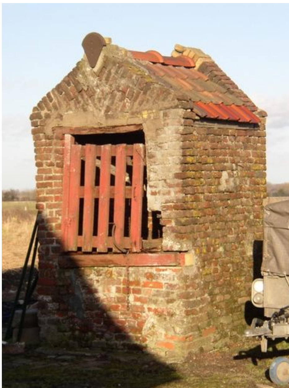
Vue générale du puits C.
