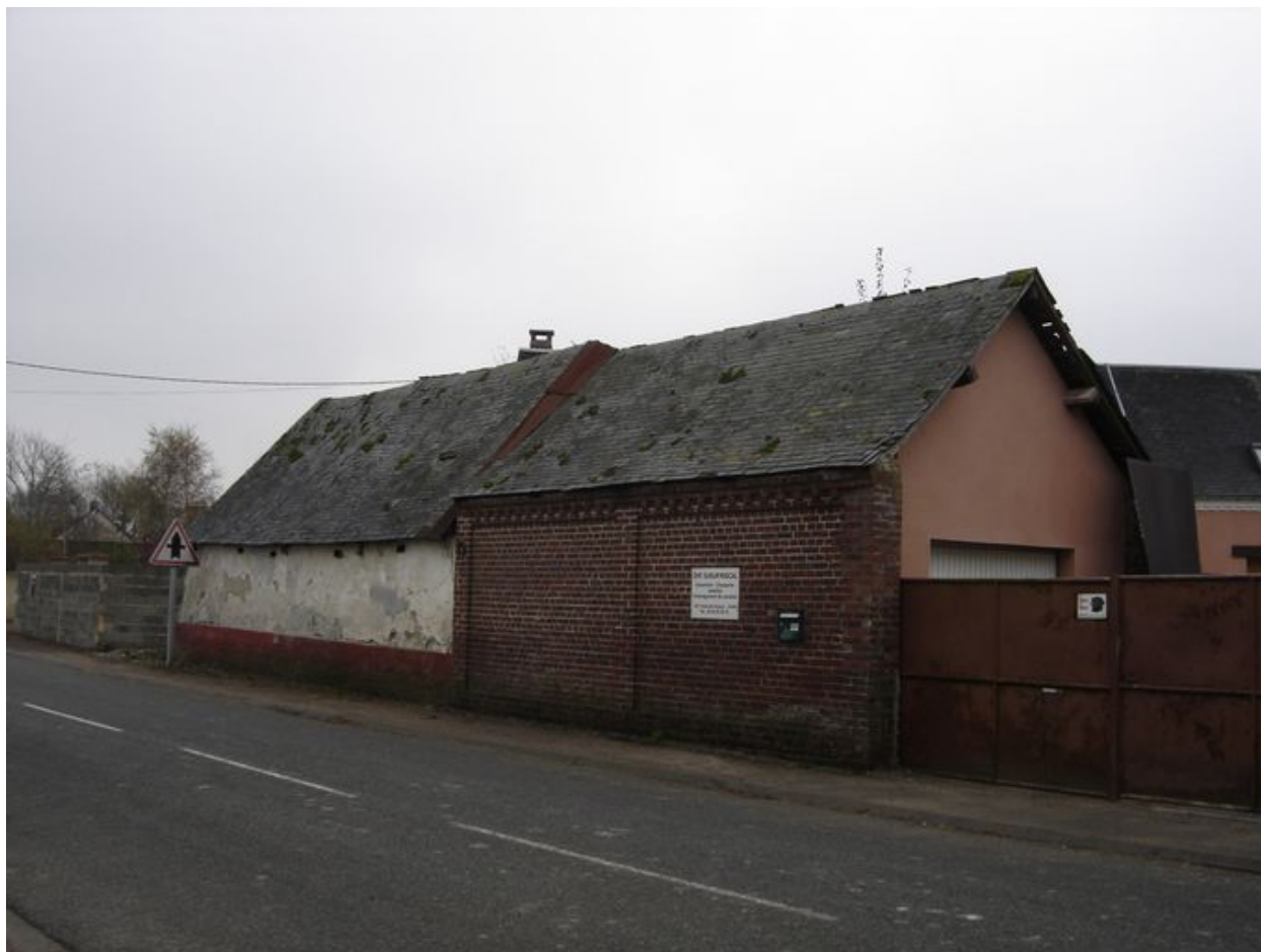
Vue des bâtiments sur rue (grange, étables).
