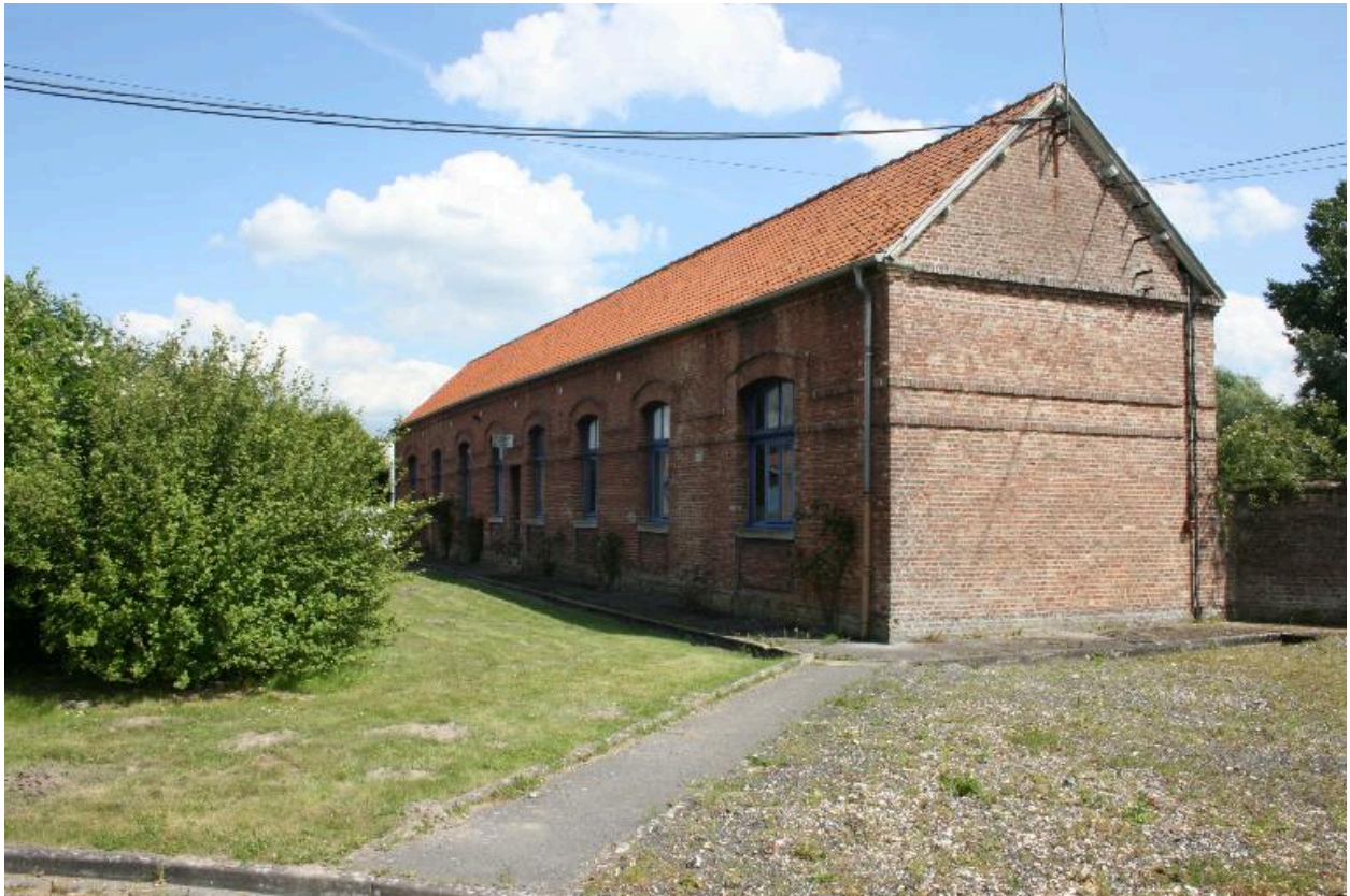
Les anciens bureaux, façade nord.
