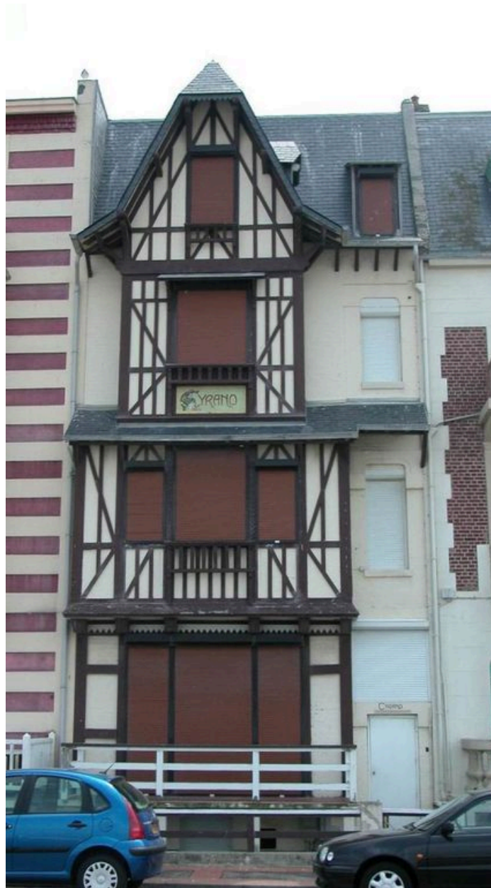
Vue d'ensemble depuis l'esplanade.
