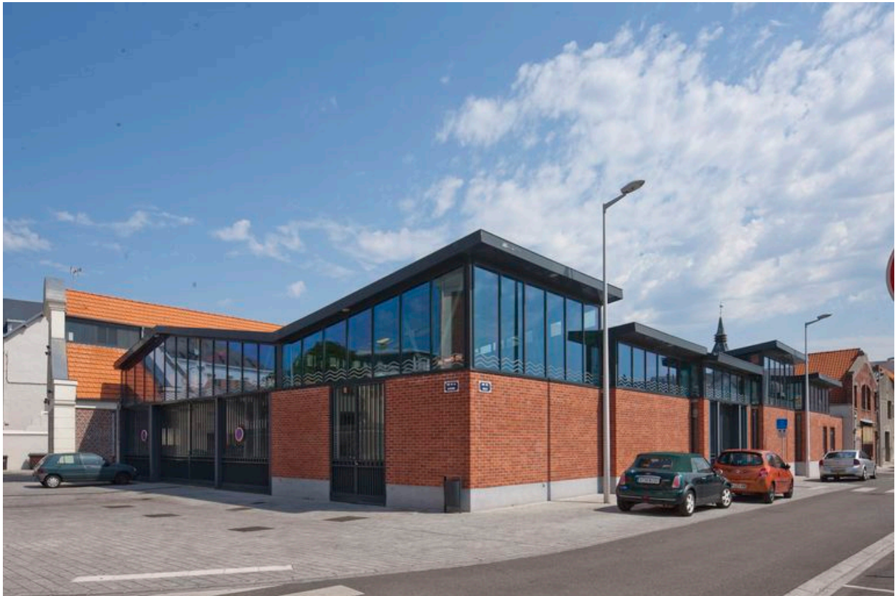
Vue générale depuis la rue des halles.
