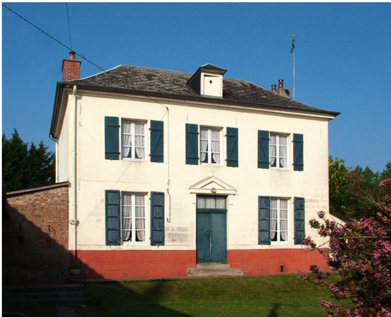
Façade sur cour.
