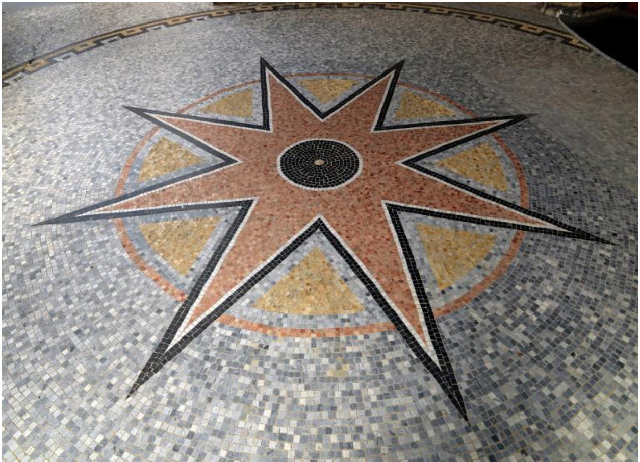
Détail du carrelage du porche.
