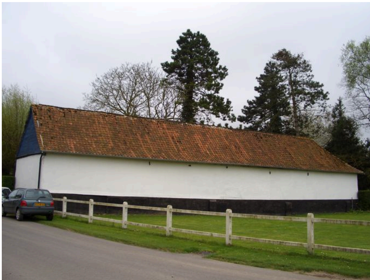
Vue postérieure depuis la rue du Marais.
