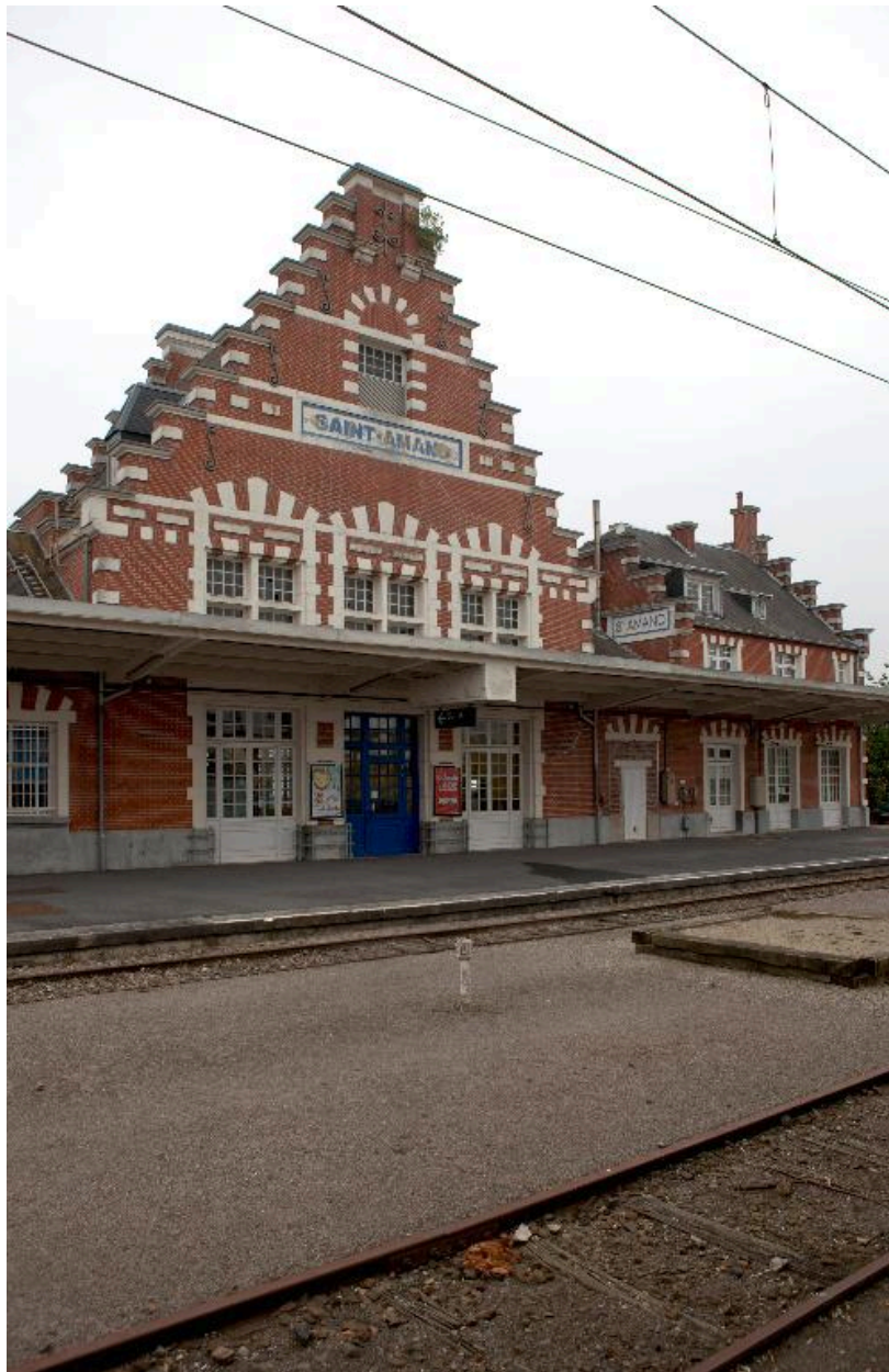
Vue générale de l'élévation postérieure.
