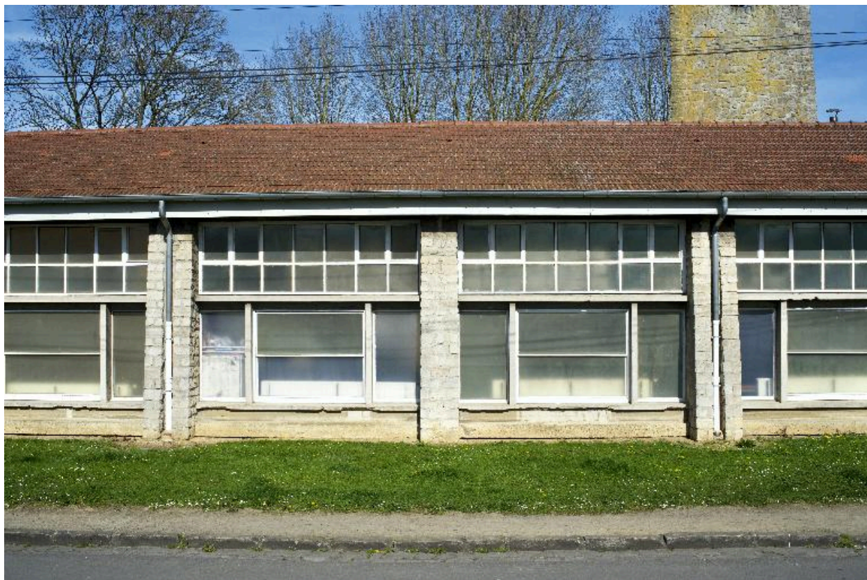
Détail de deux travées de la façade sud.
