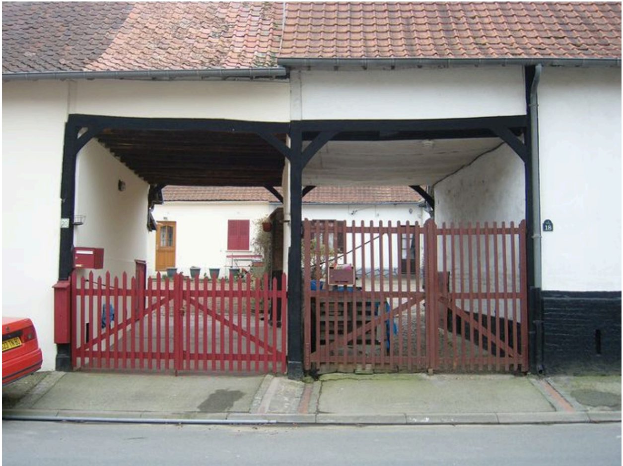
Vue détaillée des deux corps de passage mitoyens.
