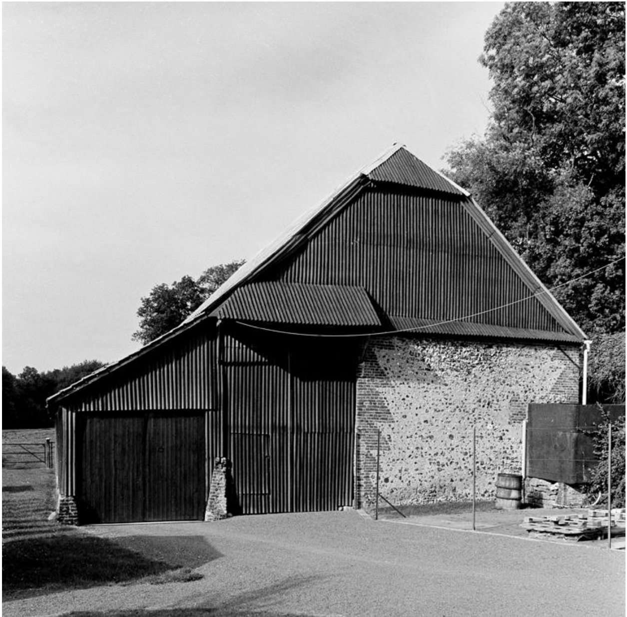
Vue de l'élévation sud de la grange.
