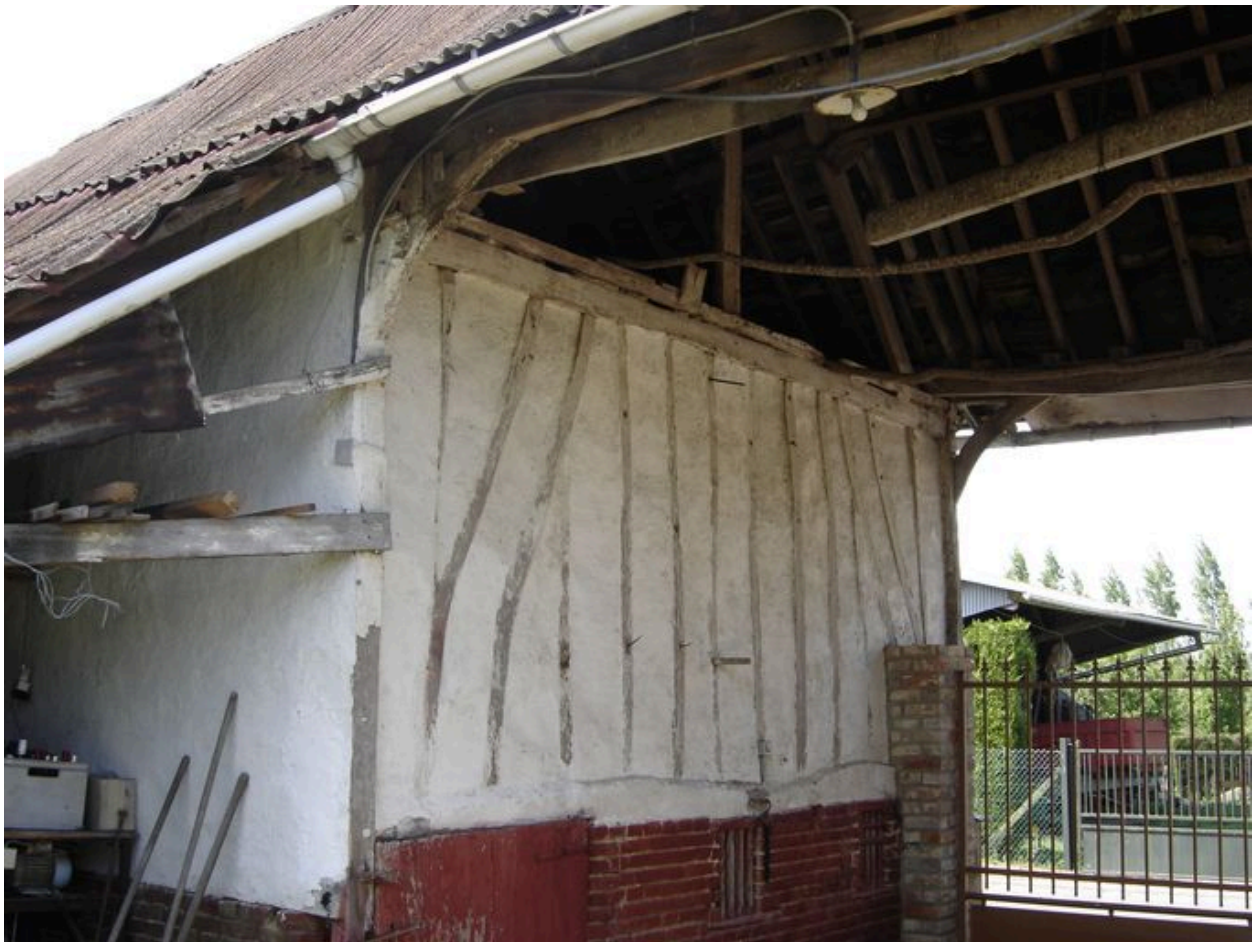
Vue du corps de passage depuis la cour.
