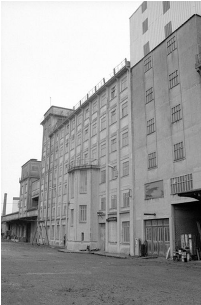
Vue d'ensemble sud-est de la minoterie en 1990.
