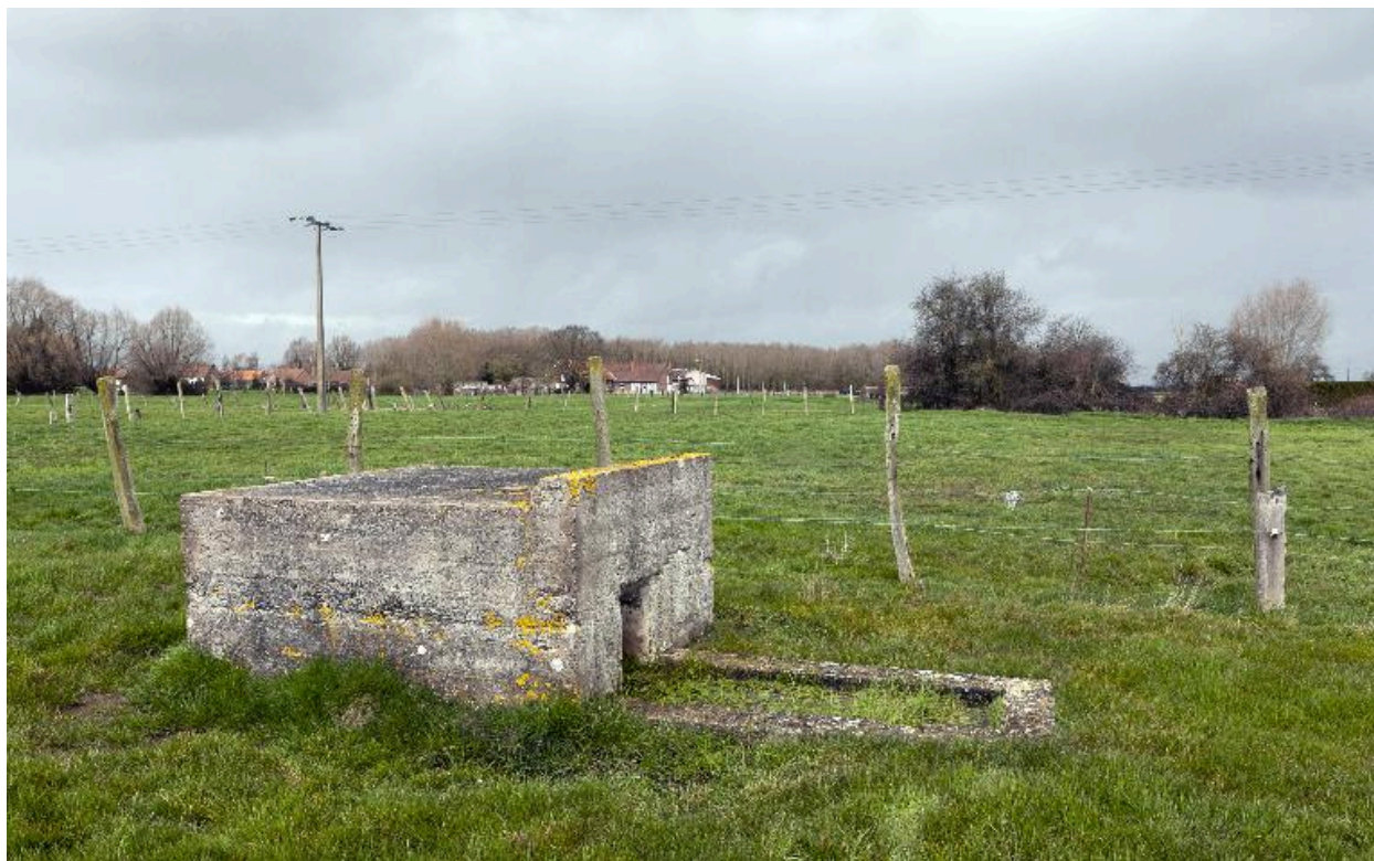
Vue de trois-quarts vers le nord
