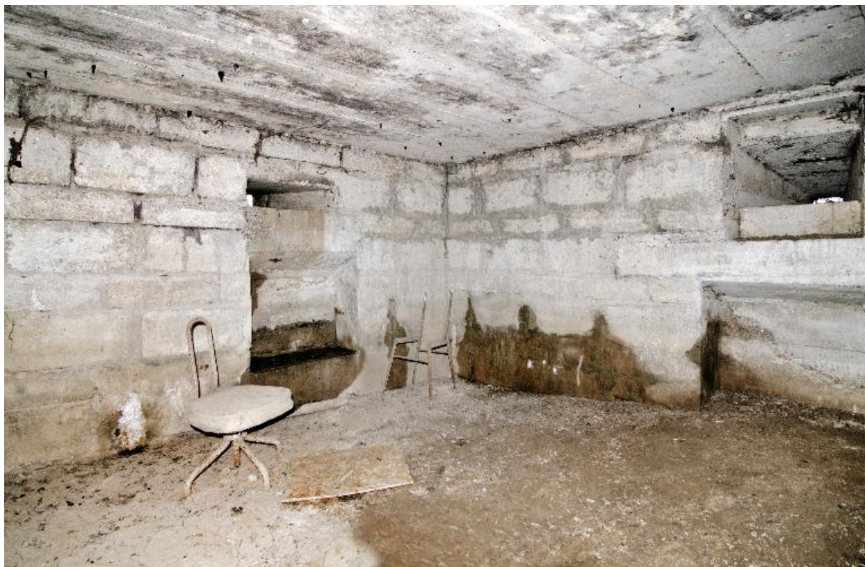
Salle nord, vers le nord-ouest. Niches et créneaux de fusillade
