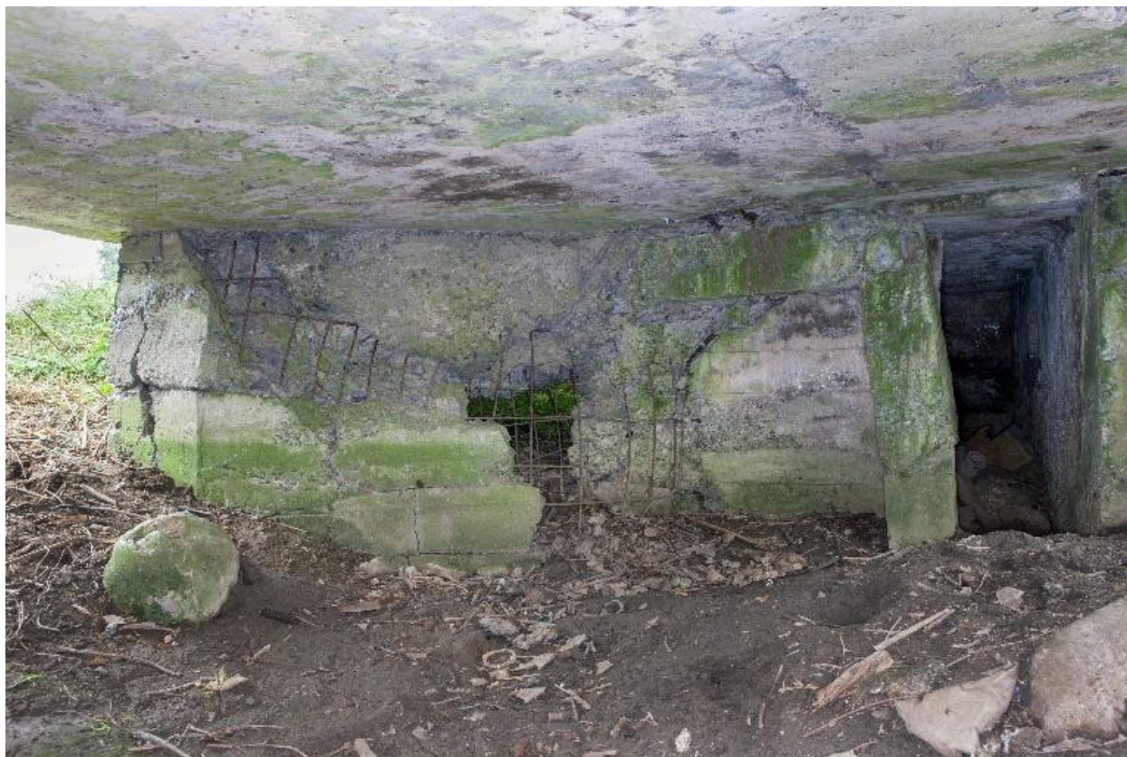
Chambre de tir, vers le nord-est
