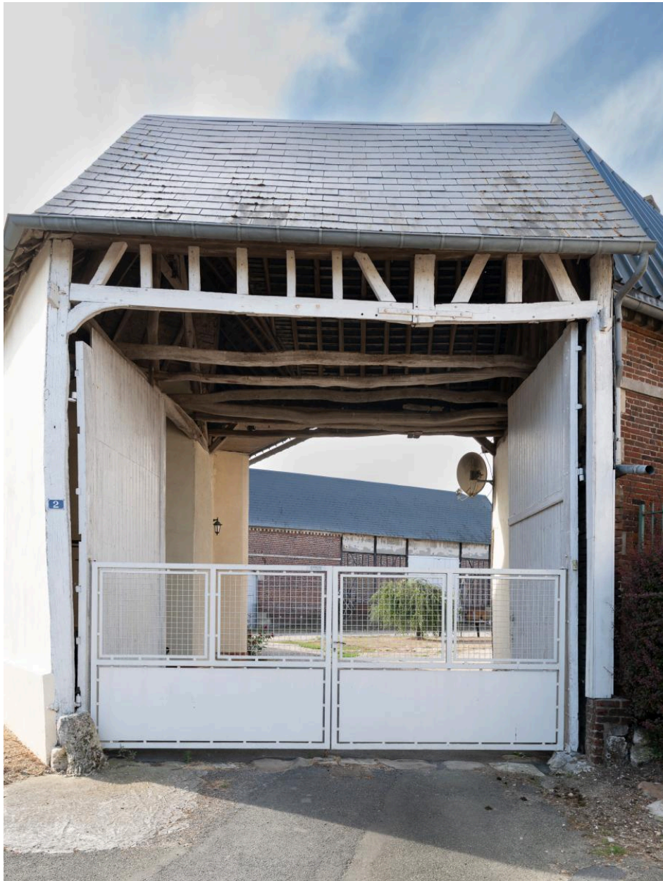
Entrée charretière de la ferme au n°2 rue des Dames, vue depuis le nord.
