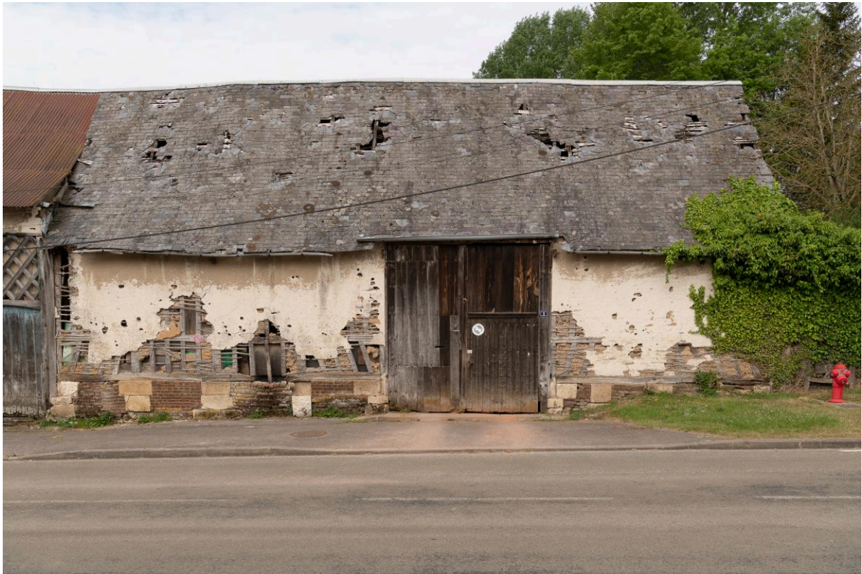
Ancienne grange sur rue avec passage charretier, n°9 rue Principale, vue depuis l'est.
