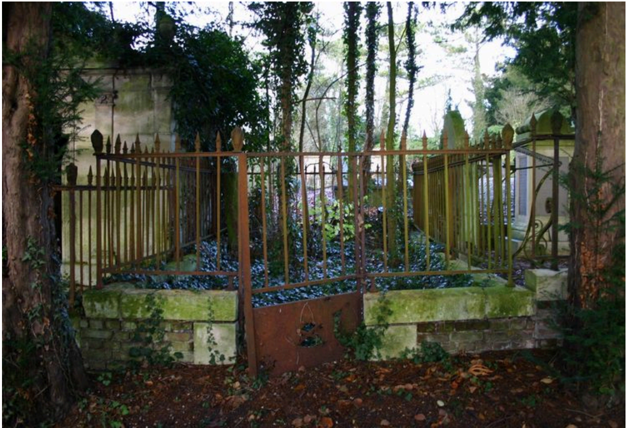
Clôture sur mur bahut, vers 1830 (E 12).
