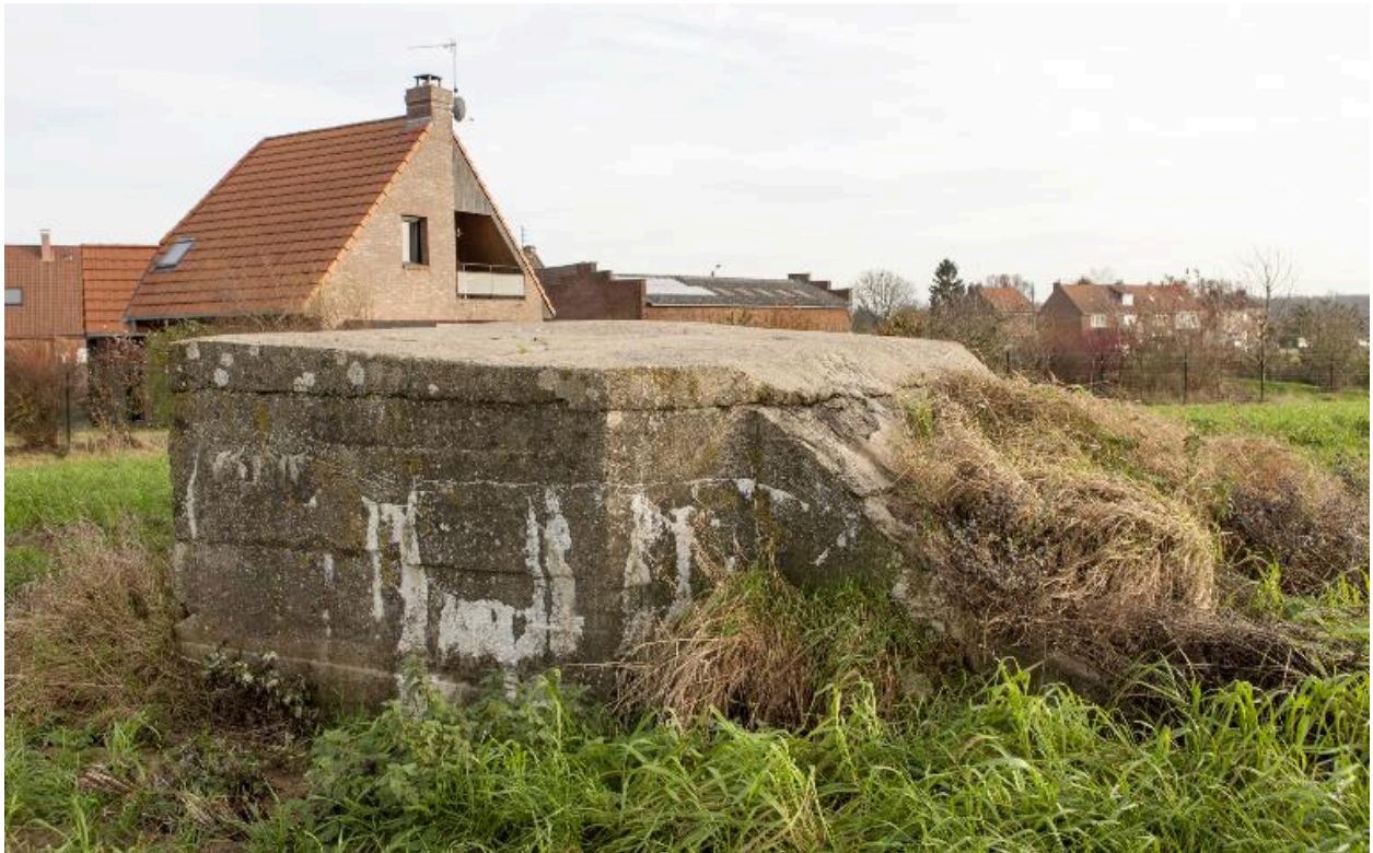
Vue de trois-quarts avant, vers le sud-est
