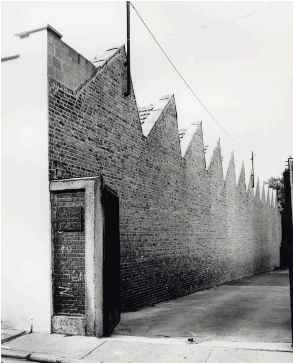
Ateliers de fabrication est.
