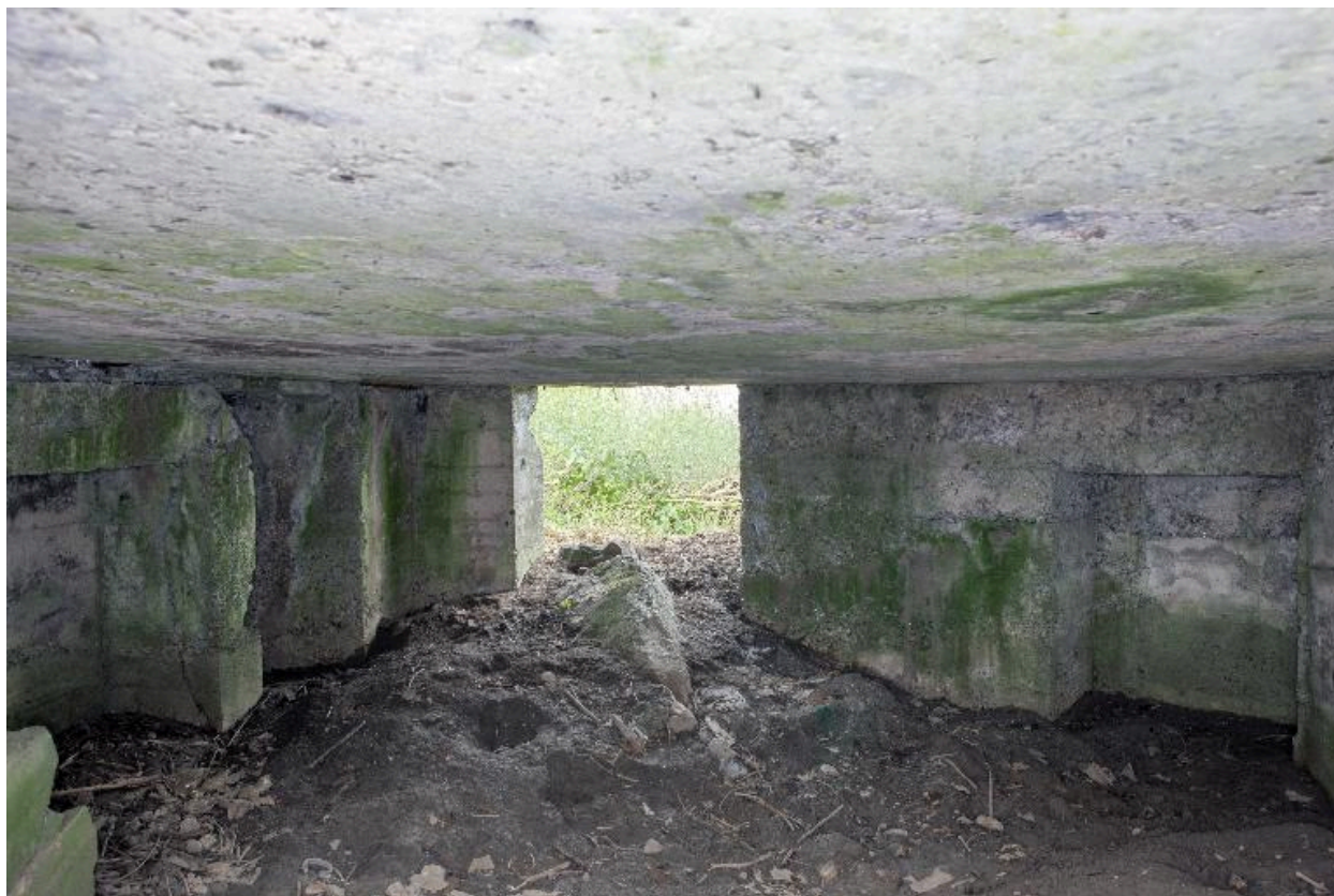
Vue vers le sud, depuis la chambre de tir
