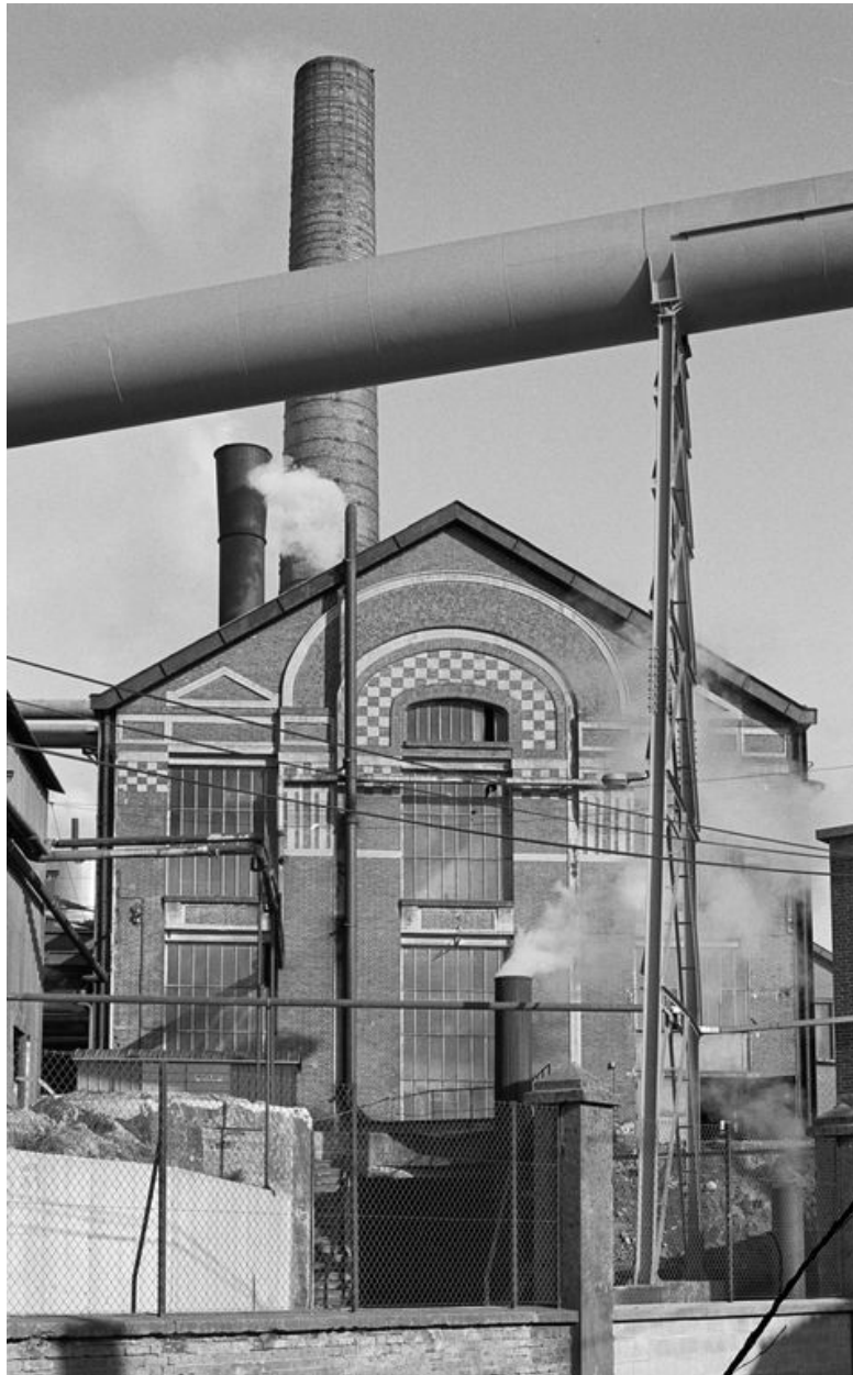
Atelier de fabrication, élévation sud.
