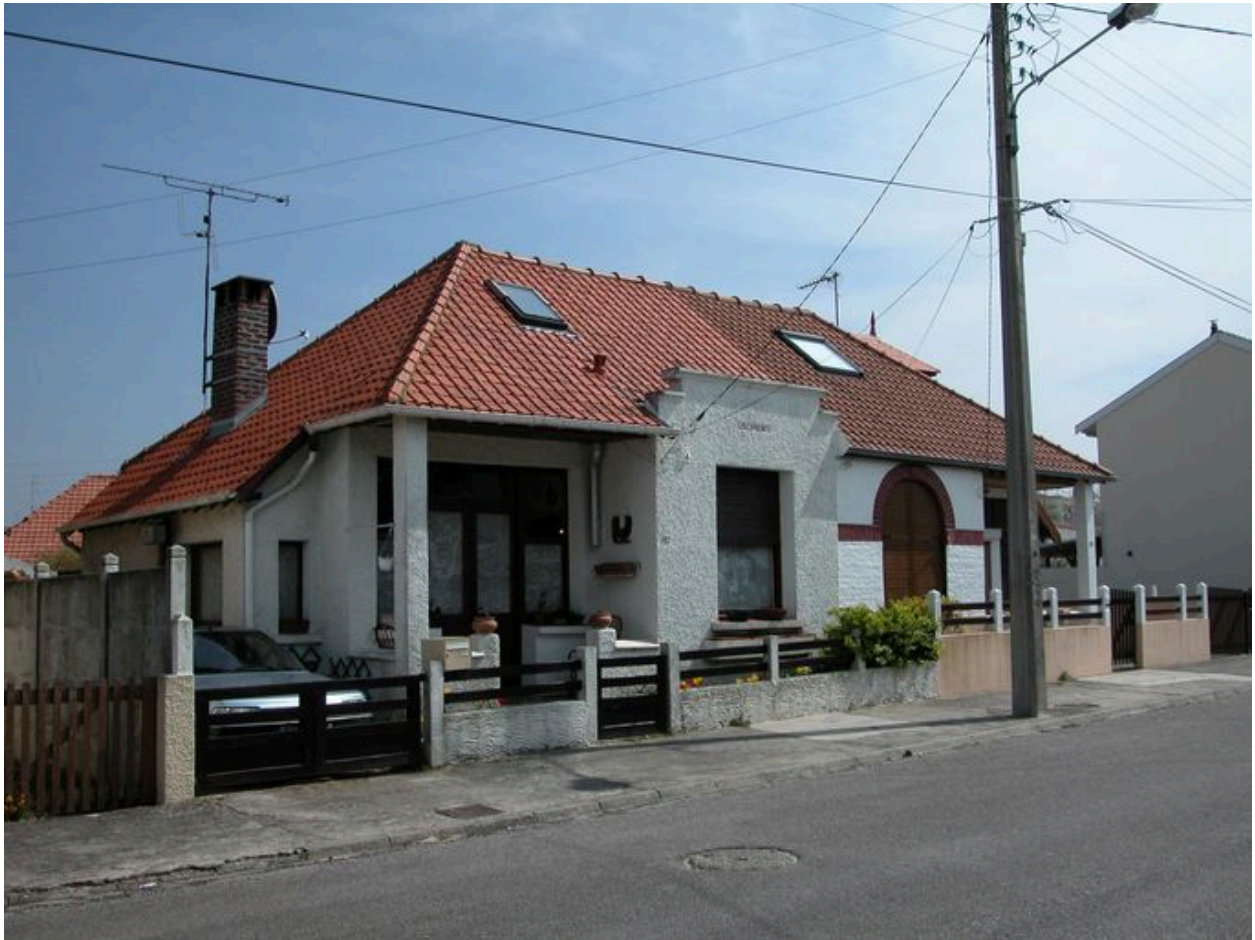
Vue d'ensemble avec 'Les Capucines' au premier plan.
