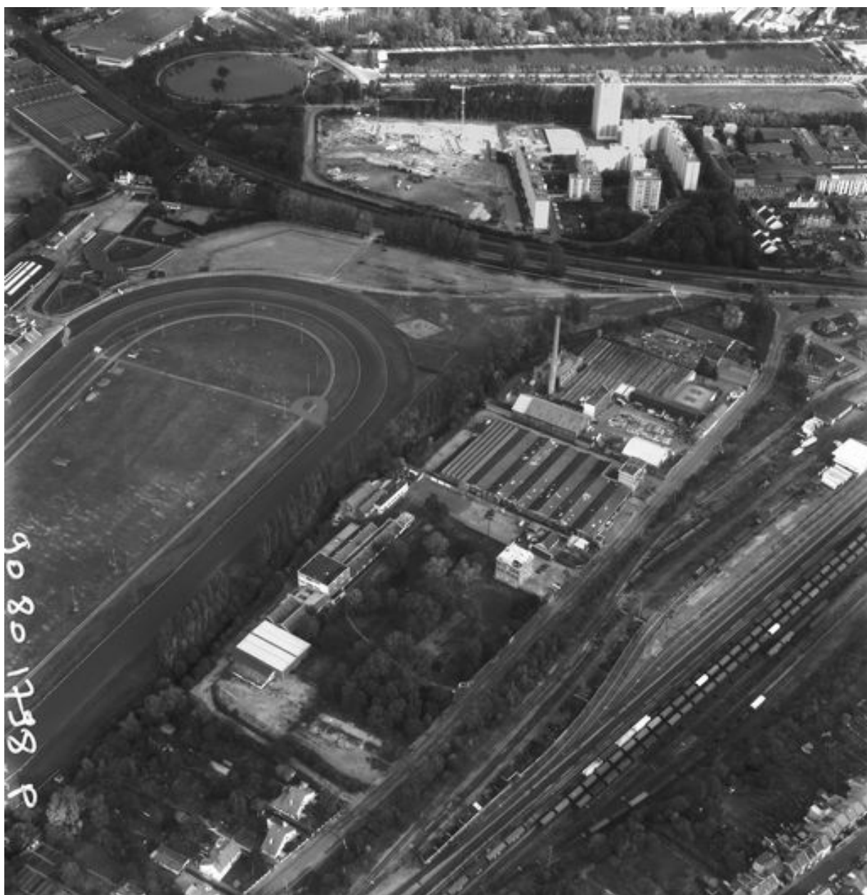
Vue aérienne, vue du sud.
