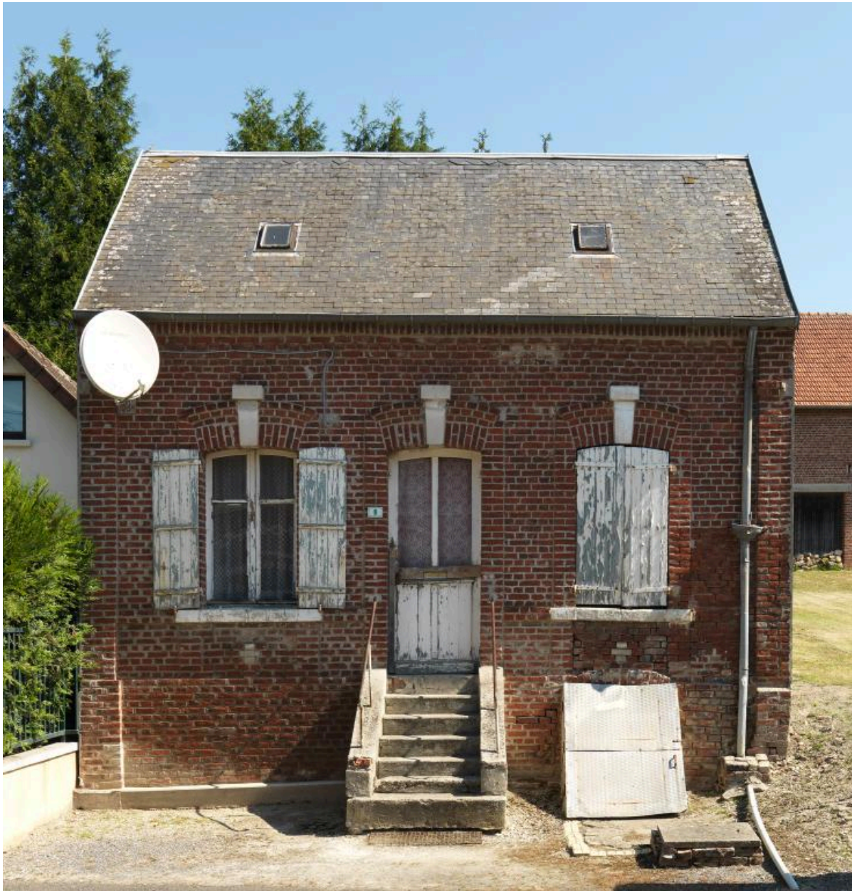
Athies. Rue du Dessous. Maison.
