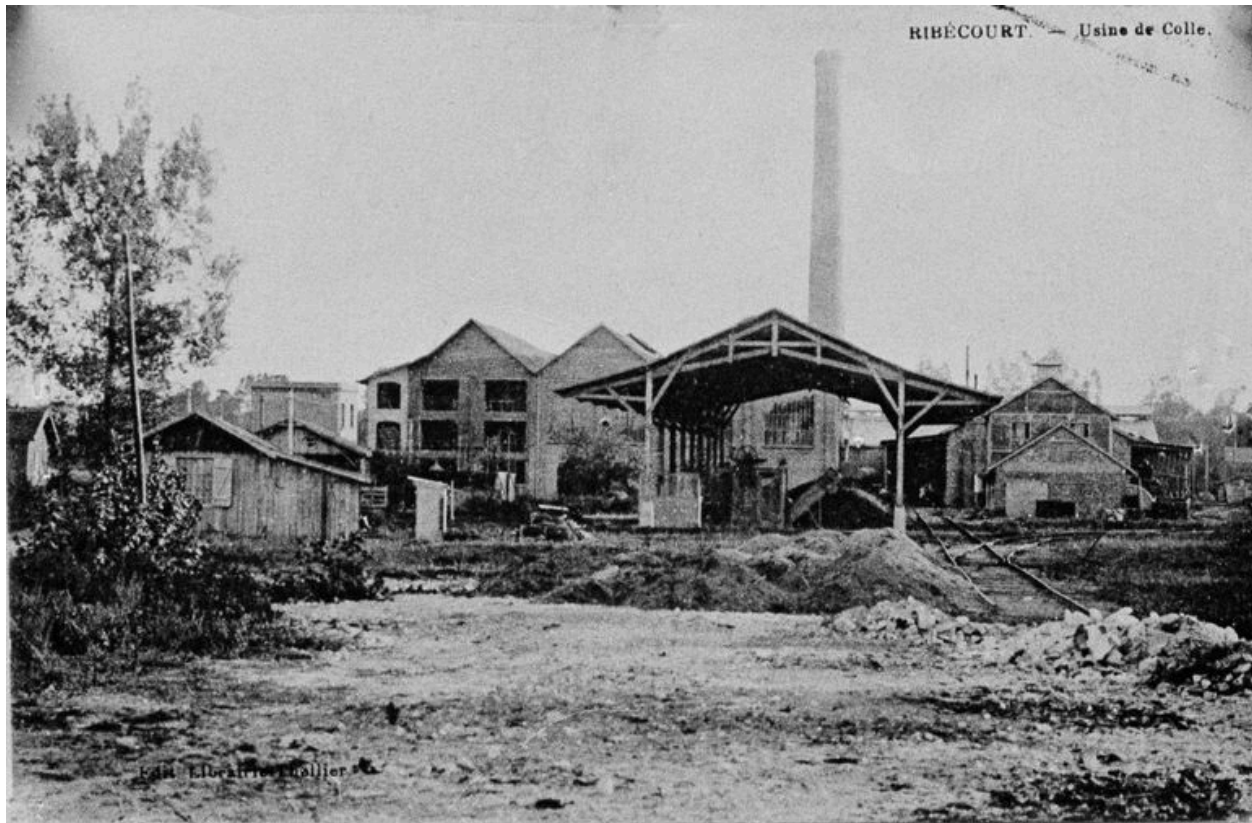
Vue générale de l'usine de colle, avant 1914 (AP).
