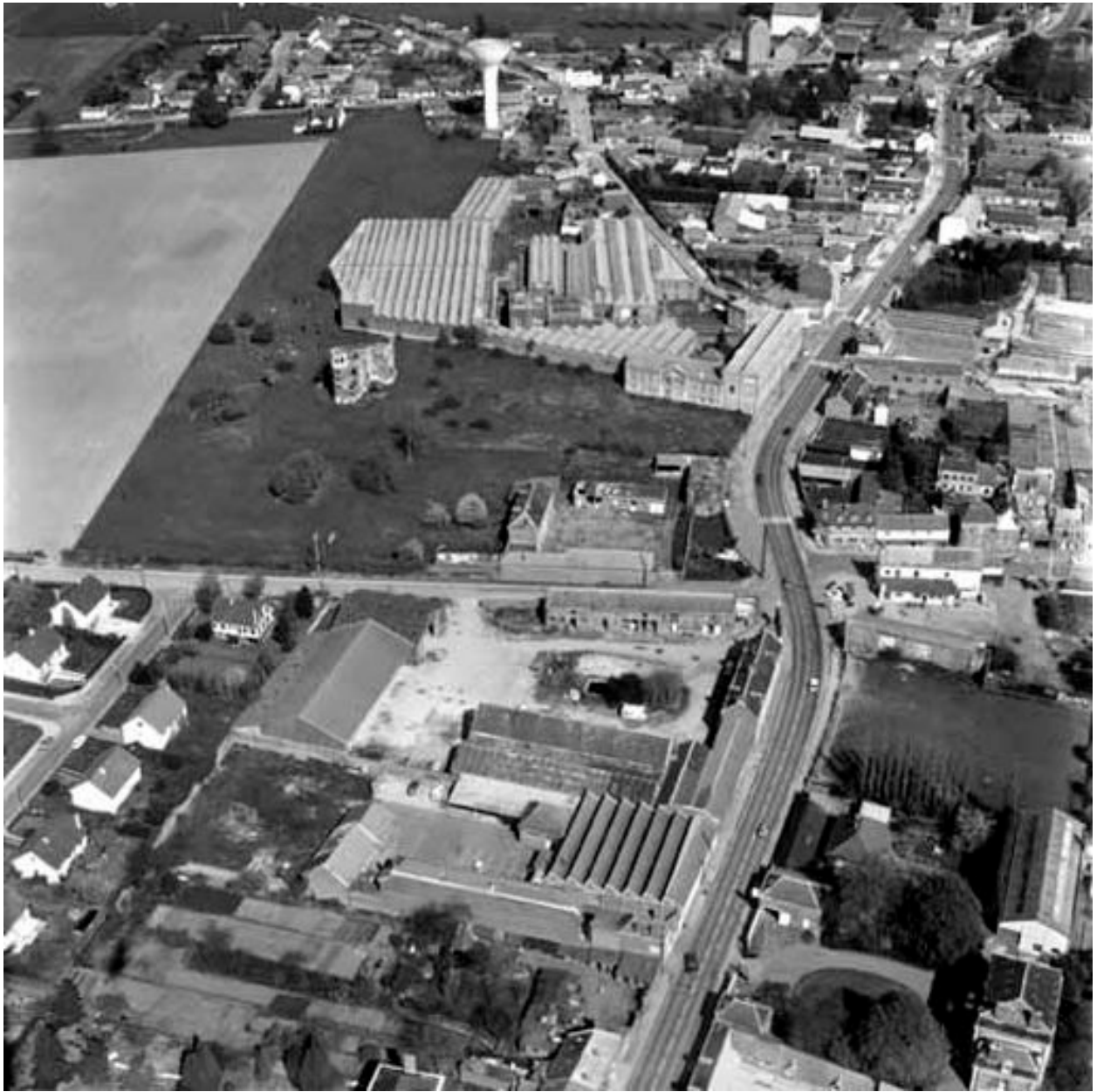
Vue aérienne, flanc sud-ouest.
