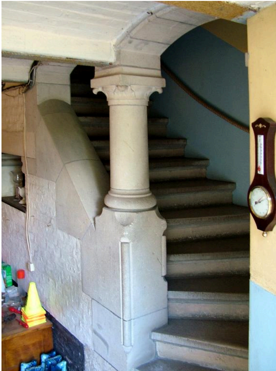
Escalier de service au sous-sol.
