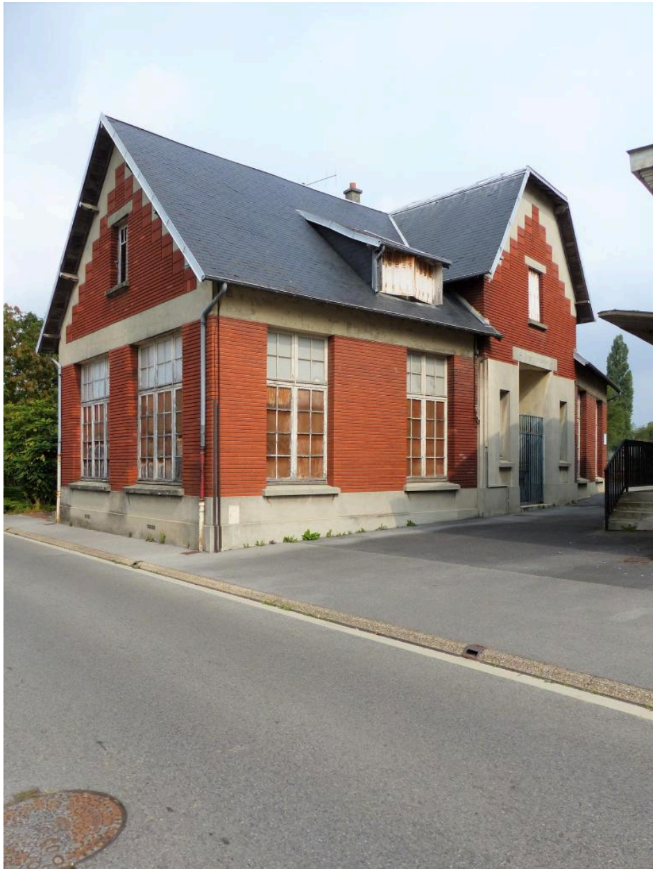
Vue générale depuis la rue Fernand-Bouyssou.
