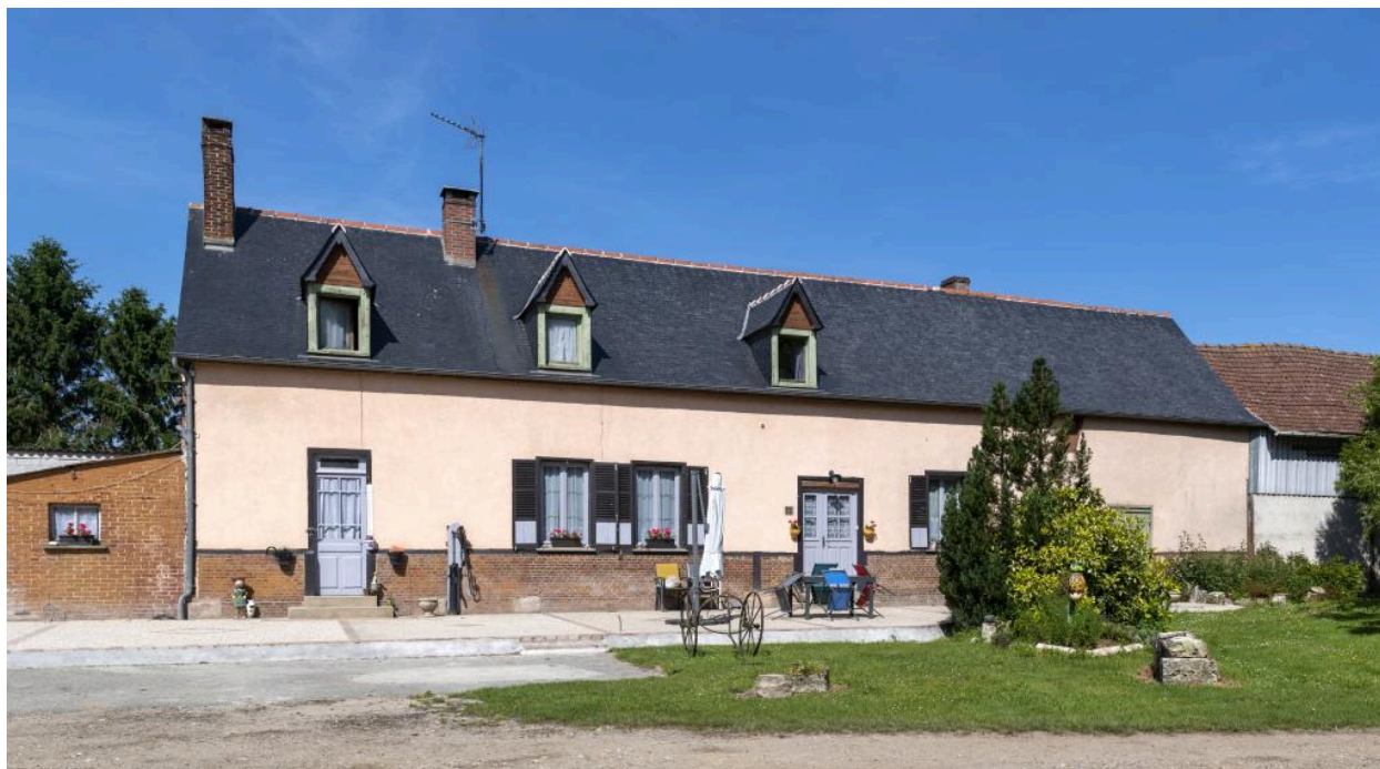
Logis de ferme, n°4 rue Cour Marin, vue de la façade depuis l'est.
