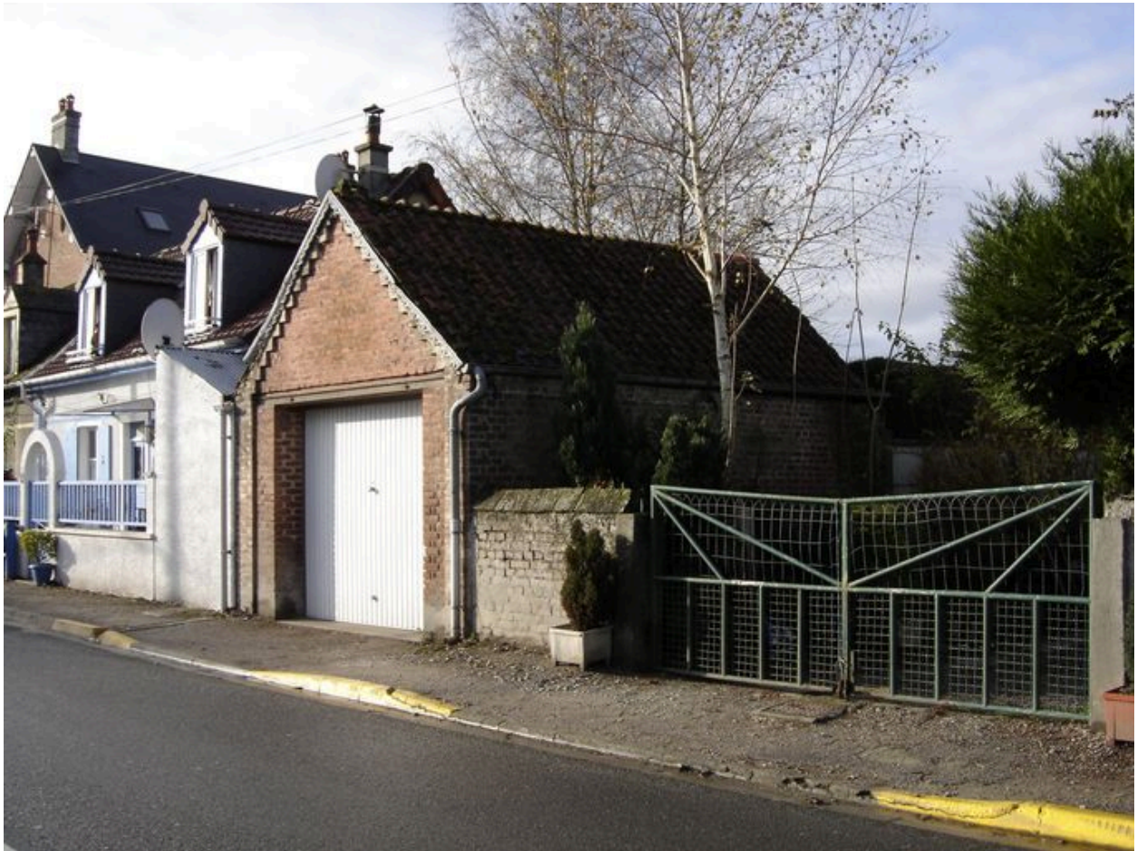
Détail de l'annexe.
