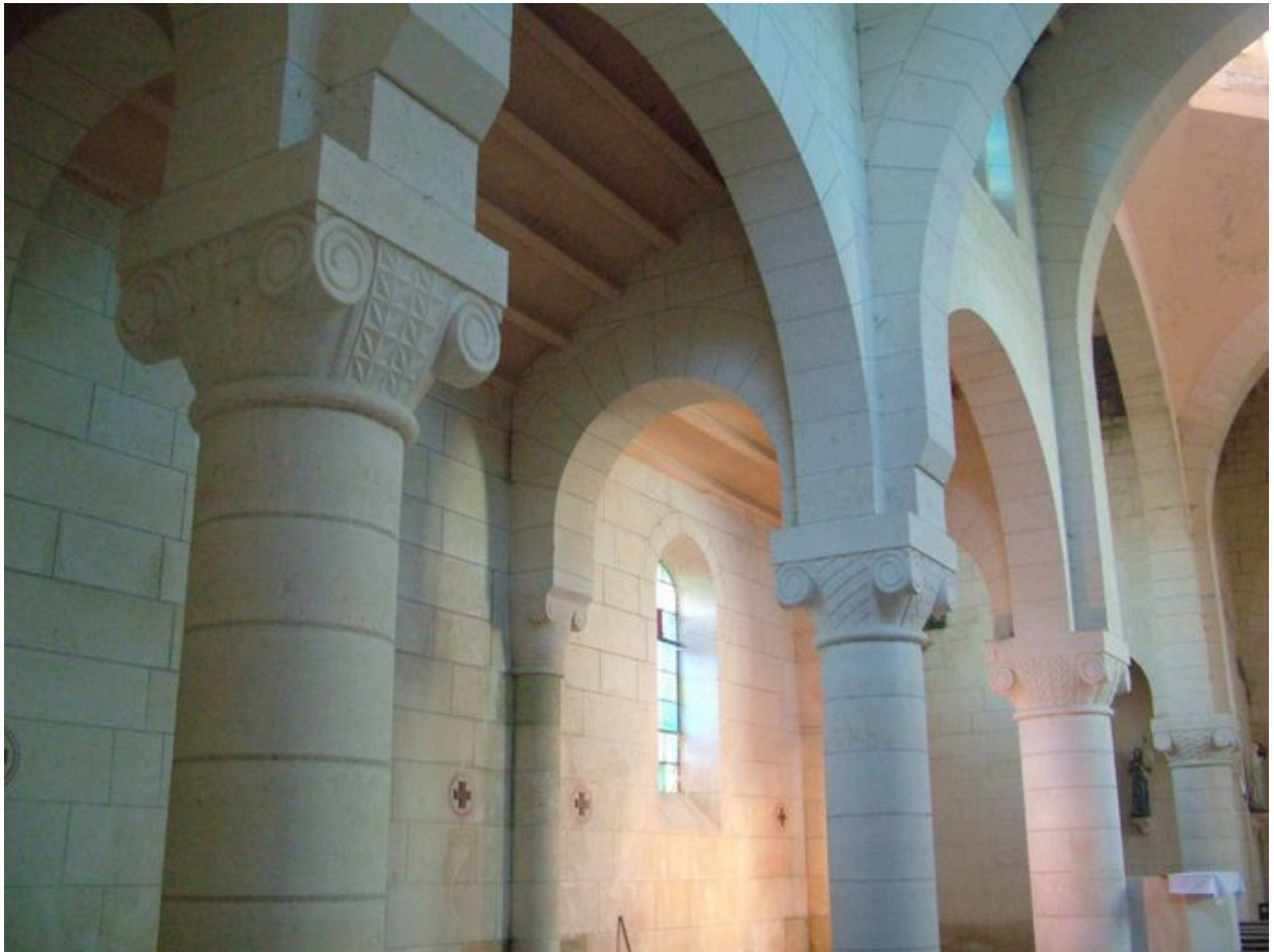
Vue des chapiteaux de la nef.
