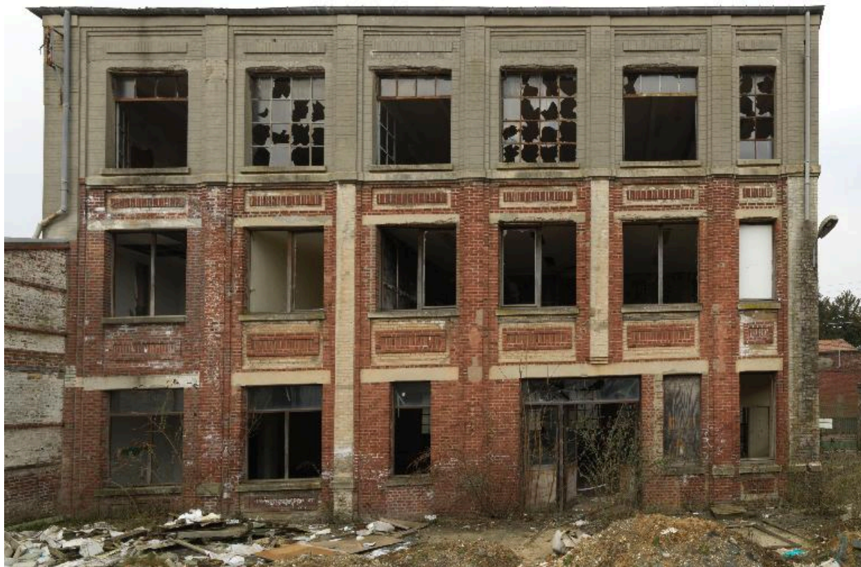
Façade postérieure du bâtiment principal sud.
