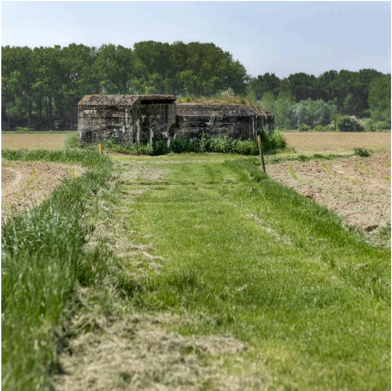
Vue latérale, vers l'ouest.
