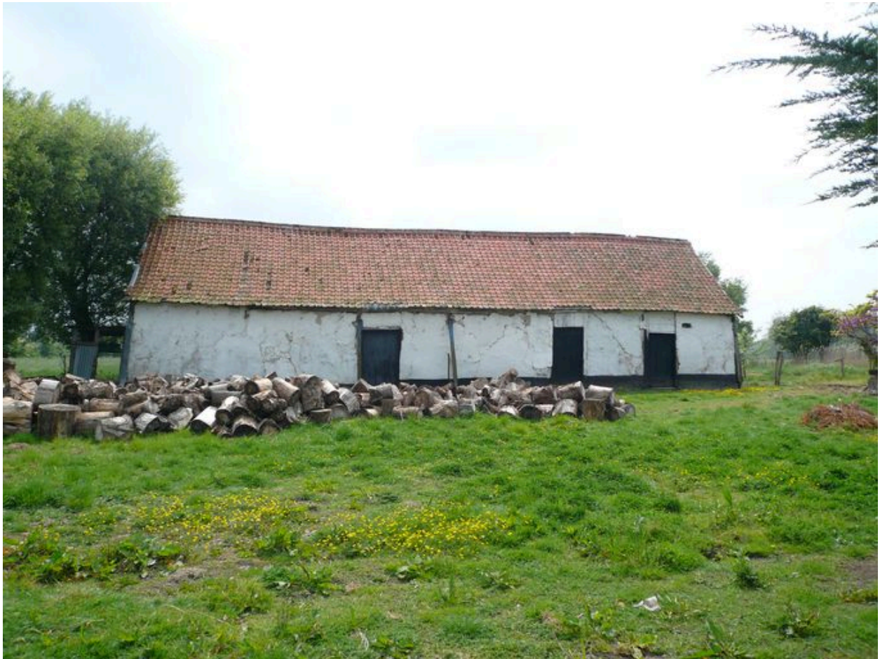
Vue des étables en fond de cour.
