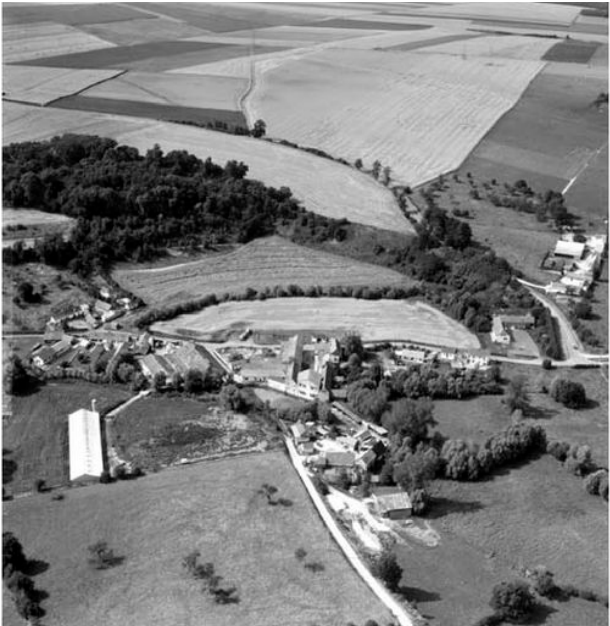
Vue aérienne, flanc est.
