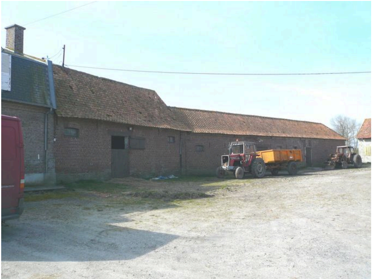
Vue des écuries dans le prolongement du logis.
