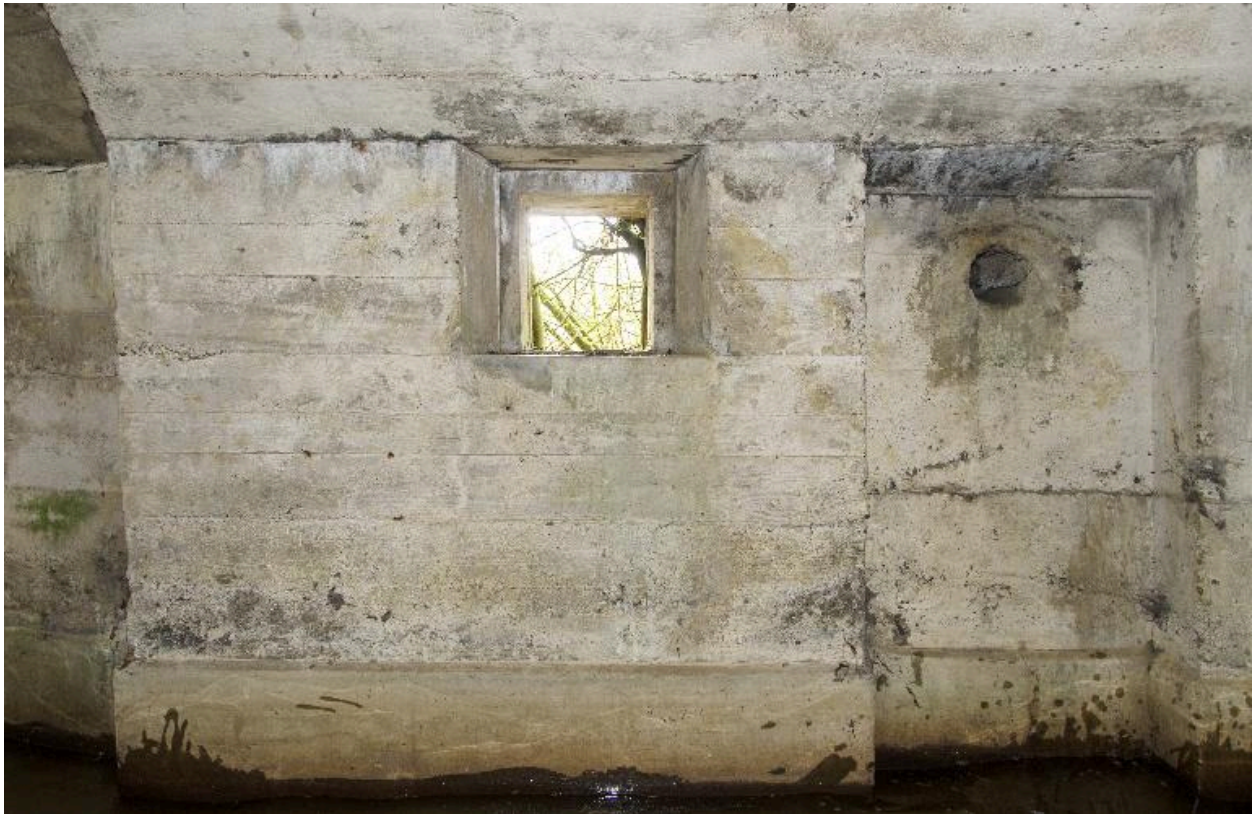
Baie dans l'élévation sud (pour escamoter la mitrailleuse ?) et conduit d'aération.
