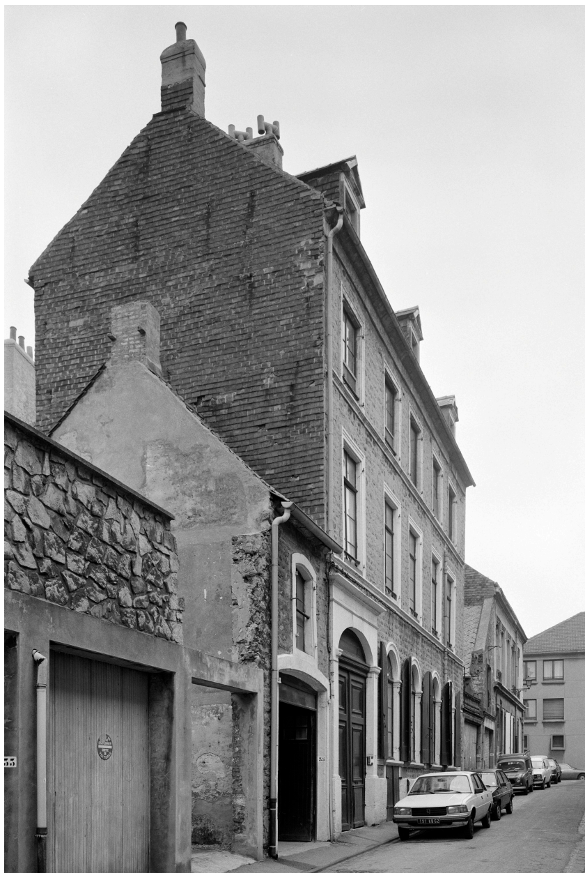
Immeuble, 33 rue de l'Oratoire.
