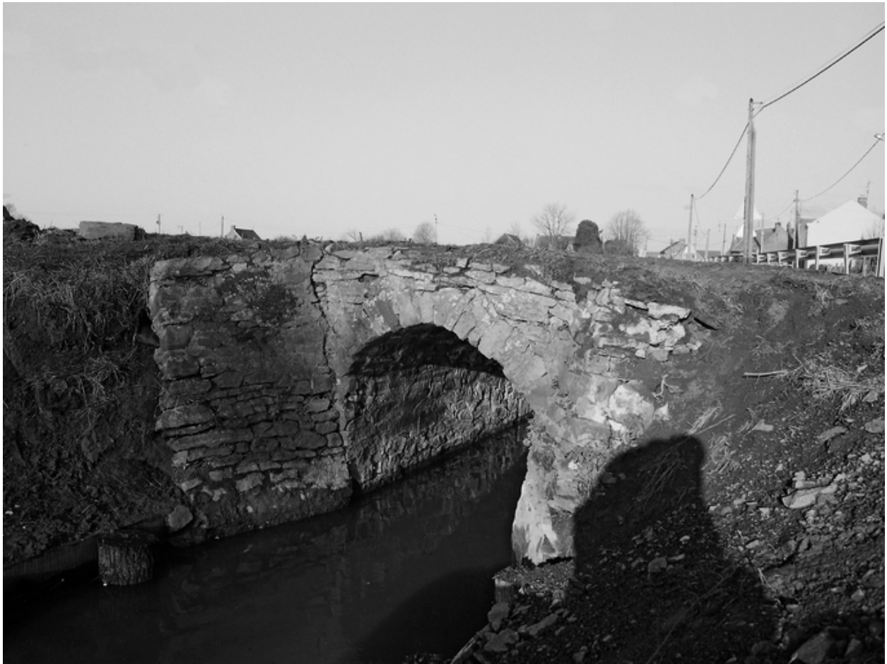
Le ponceau de la Cateria, vue générale.
