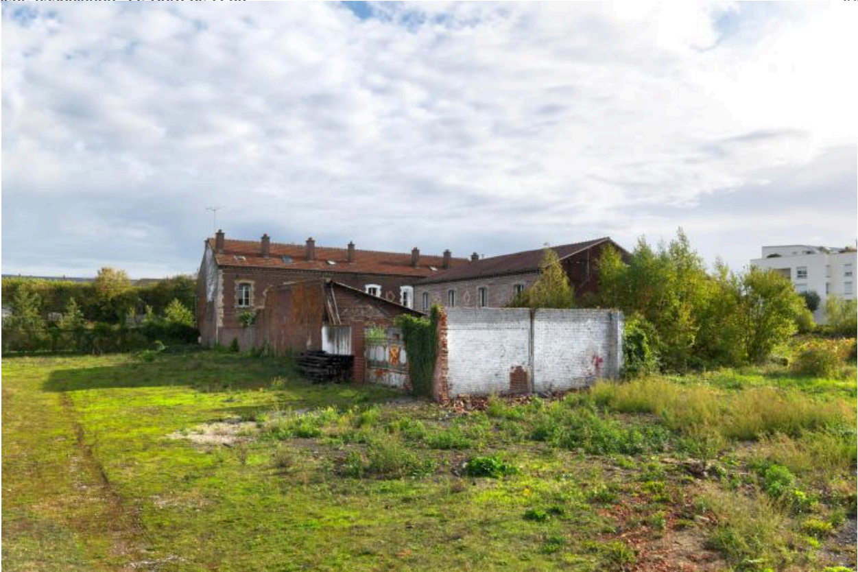
Ancienne scierie Delaplace : vue de l'enclos actuel des bâtiments restants depuis le nord-ouest du site
