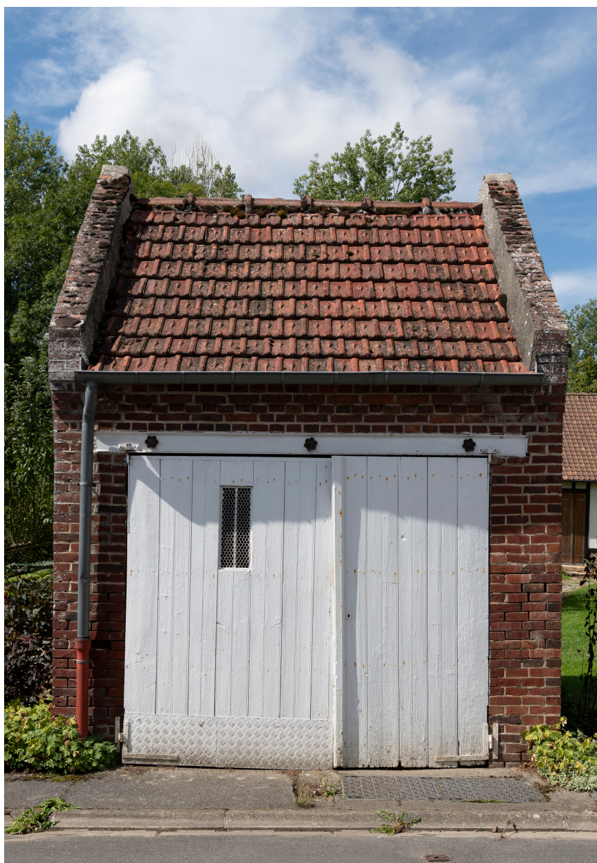
Ancienne remise des pompes à incendie de Vendeuil, vue depuis le sud-est.
