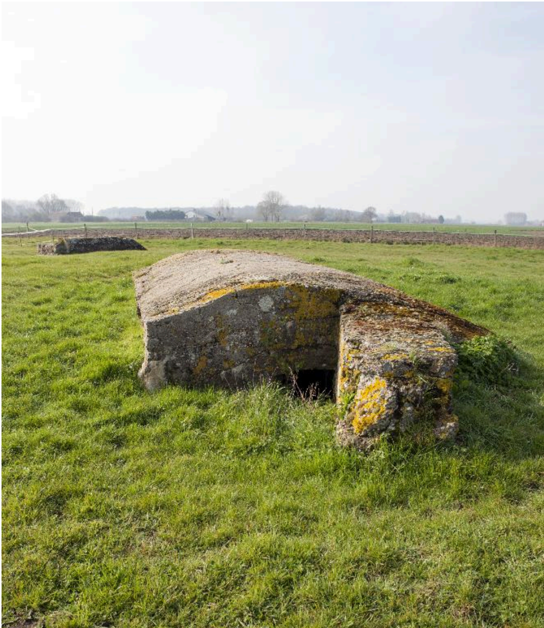
Vue des deux casemates, vers le sud. Au premier plan, l'entrée nord et son mur pare-souffle
