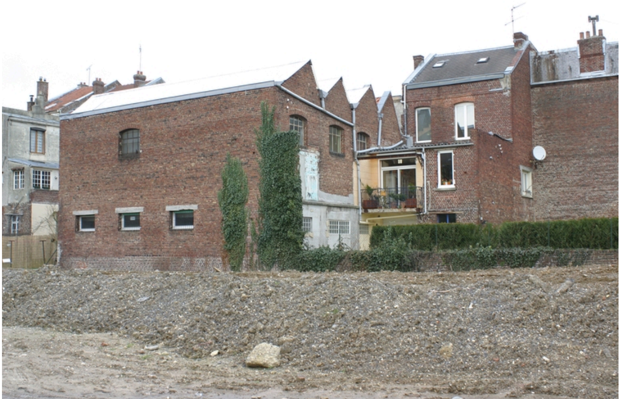
L'ancienne usine Duchemin vue depuis la ruelle Flamant.
