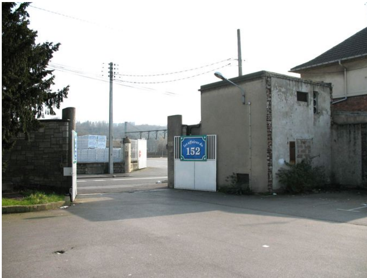
Entrée de l'usine et transformateur électrique.
