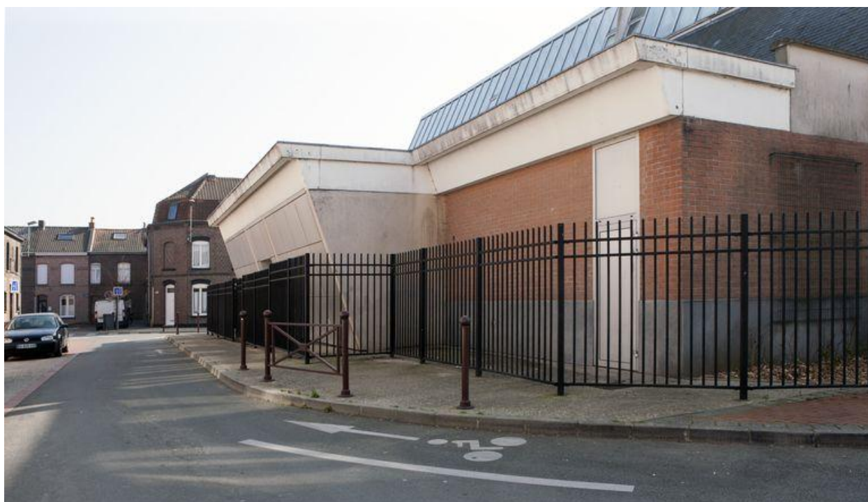
Flanc droit de l'église.
