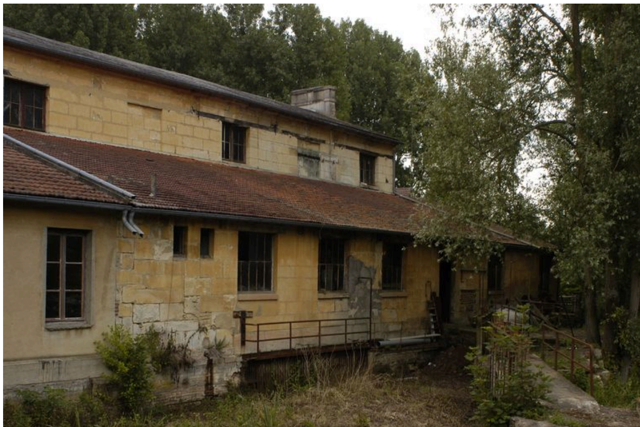
Façade postérieure de l'atelier de fabrication, détail du canal d'amenée et de l'ouverture du coursier.
