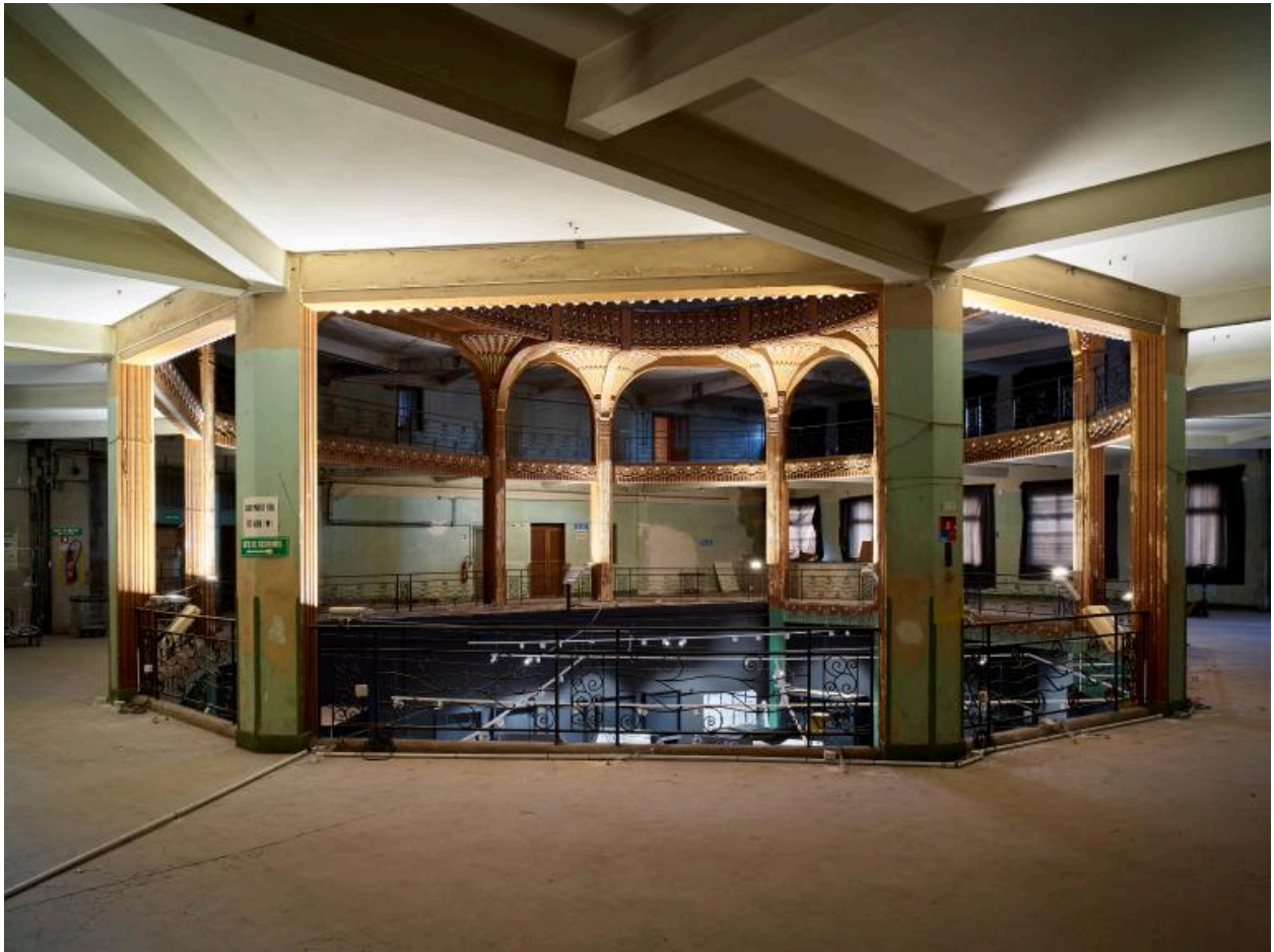
Atrium secondaire ovale, vue d'ensemble depuis le premier étage.
